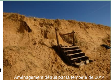
Aménagement détruit par la tempête de 2014
